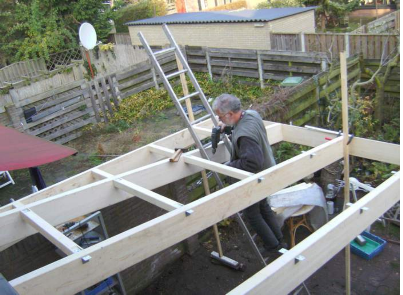
6 november 2008: de montage van de tussenbalkjes waarop later het veiligheidsglas van het dak zal komen te liggen.
