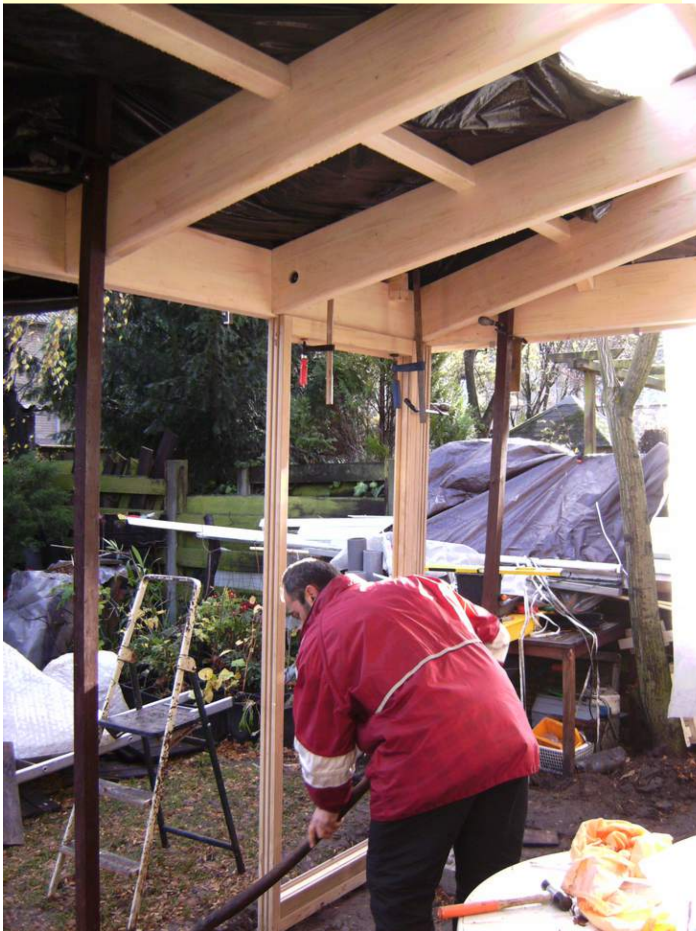
11 november 2008: het eerste kozijn wordt vast gehangen aan de draagbalk.
